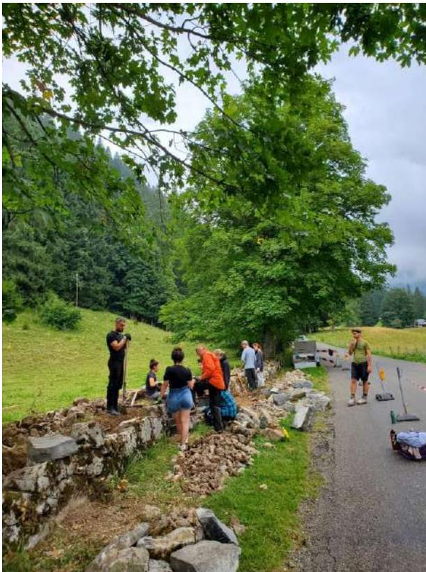
Im August machte das Projekt Building Walls – Breaking Walls Halt in Gryon in der Romandie. Hier konnten durch die Zusammenarbeit der Teilnehmenden und der professionellen Trockenmauerern über 20 Meter einer bestehenden Trockenmauer saniert und teilweise neugebaut werden. Für viele der Teilnehmer:innen war es das erste Mal in einer solch alpinen Umgebung und sie waren begeistert von der Landschaft und den umliegenden Bergen. Auch diese Woche war ein voller Erfolg!
