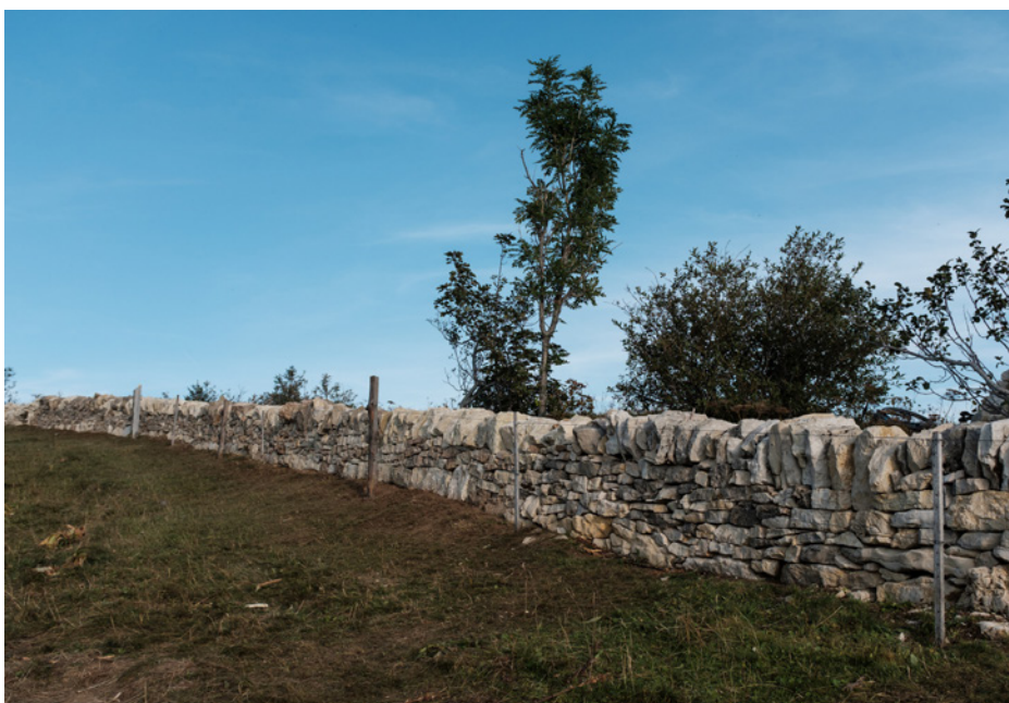
Der fertige renovierte Teil der Mauer auf der Wandfluh mit dem wunderschönen Jura-Kalkstein.
