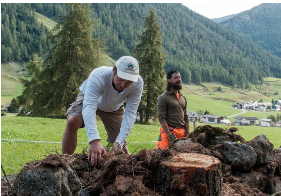
Auch Geschäftsführer Oliver Schneiter, legt Hand an bei den Mauerarbeiten.
