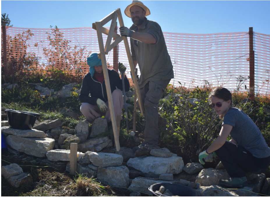
Die motivierten Teilnehmenden mit den Trockenmaurer beim Ausmessen der Breite.
